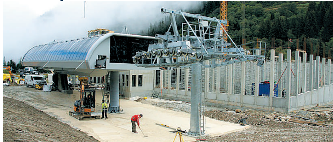
Construction site for the Pré-Saint-Esprit chairlift
